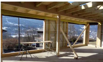
plancher intermédiaire plafond plat
