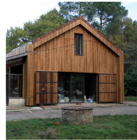
Façade Nord-ouest ouverte
