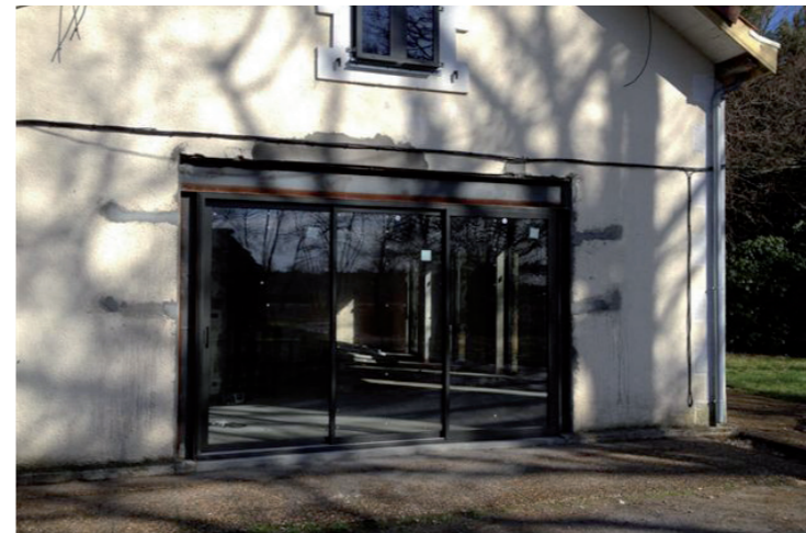
Travaux d'ouverture extérieur
