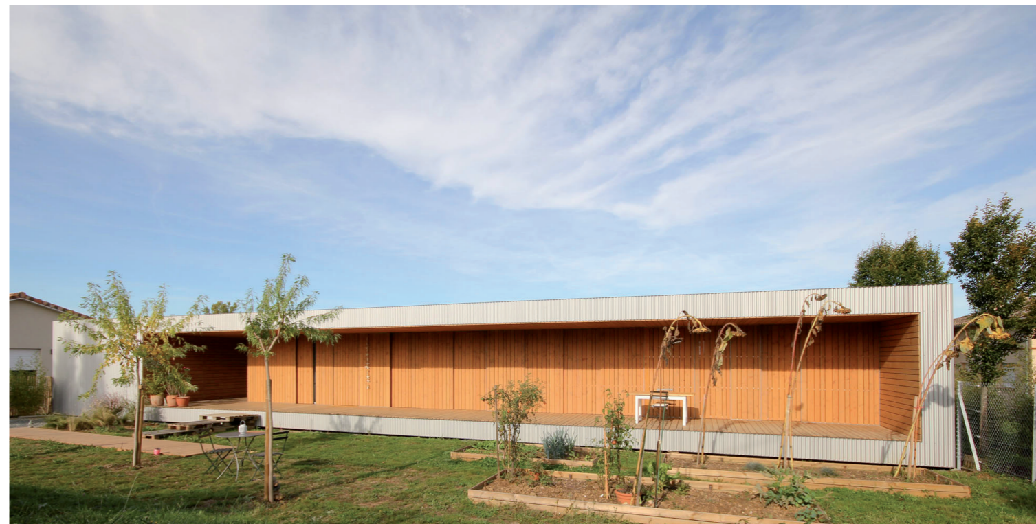
Façade Sud fermée
