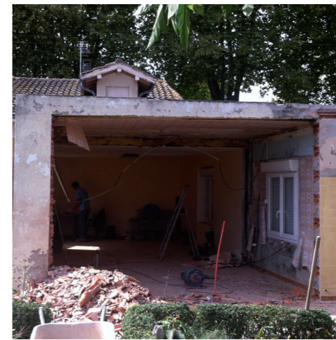
Façade Nord-est en travaux
