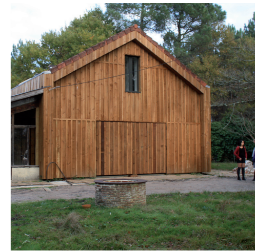
Façade Nord-ouest fermée
