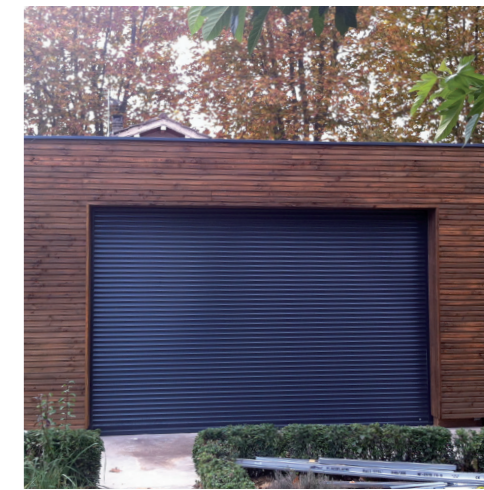
Façade Nord-est fermée
