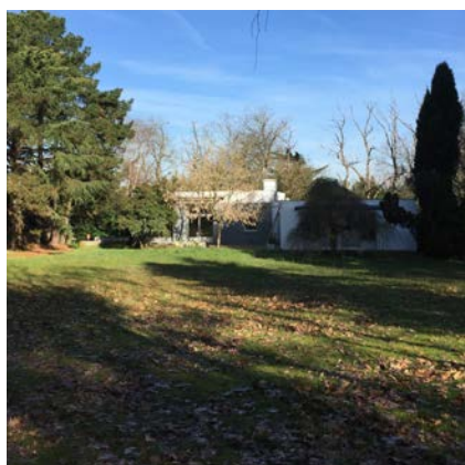
Création d'une école / restructuration d'un bâtiment existant. Bouguenais (44) 420 m 2 - € 263 000 HT Maîtrise d'ouvrage : privée Livré 2020
