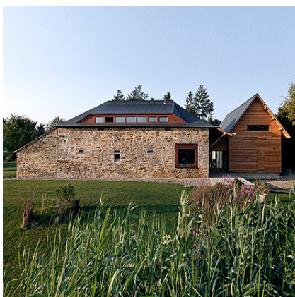
Réhabilitation et extension d'une ferme à Craon (Mayenne) 263 m 2 SHON - 330 000€ HT Maîtrise d'ouvrage : Privé Equipe de maîtrise d'œuvre : MOE : LADAA + JKA Livré 2013
