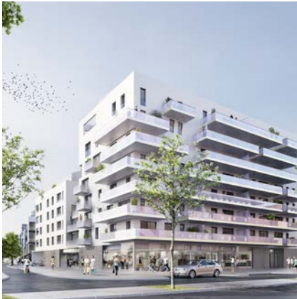
98 Logements + activités à Toulouse (31) Maîtrise d'ouvrage : Belin Promotion Maîtrise d'oeuvre : AAUPC (Direction de projet Nicolas Gicquel) Surface : 5200 m 2 SP - 6,7 M€ 2014
