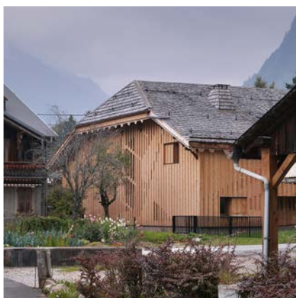
Réhabilitation d'une ferme : «Villa Solaire» Morzine | Haute-Savoie (74) 493 m 2 SHON - 1,1 M€ HT Maîtrise d'ouvrage : Privé: MOE : JKA (Jérémie Koempgen) Collaborateurs : FUGA design Livré 2012
