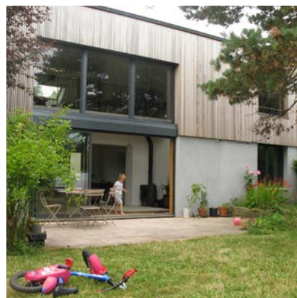
Surélévation et ré-agencement d'une maison individuelle à Nantes (44) 170 m 2 SP - 100.000 € Livré 2016
