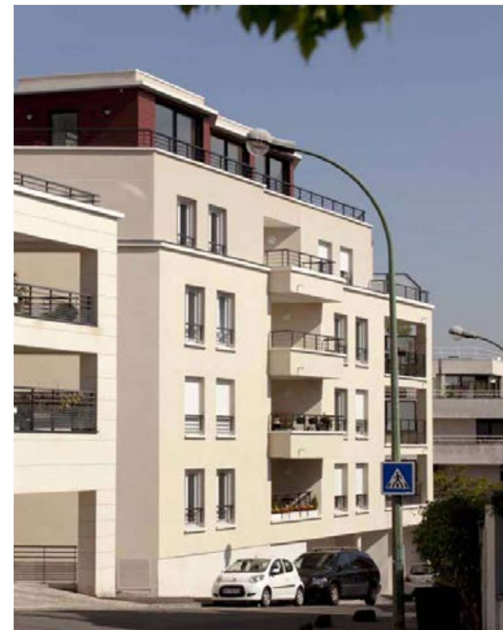
Type Construction immeuble de 33 logements Client: Plaza immobilier. Mission: Maîtrise d'oeuvre conception, budget 64M. Surface SHON 1 031 m2. Chantier en cours.
