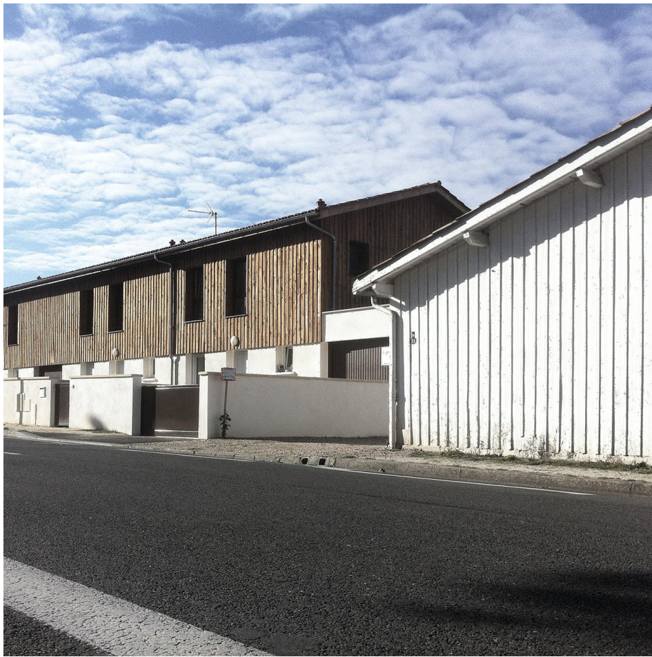
3 logements en bande à mérignac
