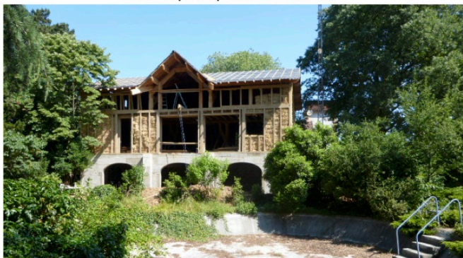
état du chantier en juin 2015
