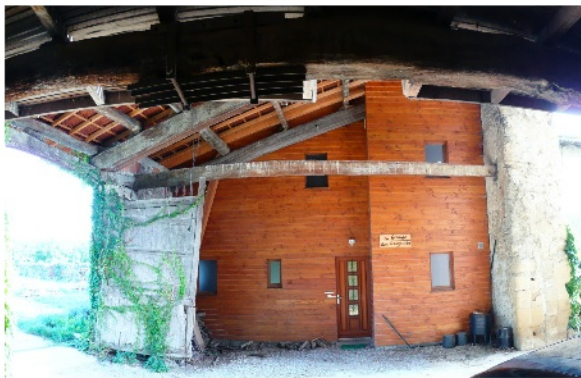
Entrée, façade nord sous auvent
