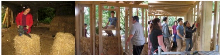
chantier participatif en mai 2015
