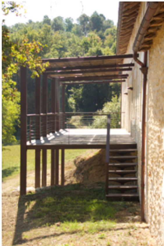
Terrasse Pergola à ossature métallique. « Maison Chastel-Rousseau » 2012/2013
