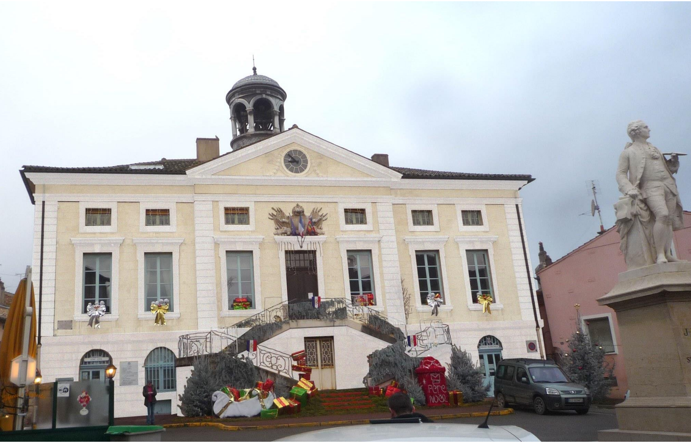
Tournus – restauration façades de l'Hôtel de Ville (CMH) conçu par Emiland Gauthey 1760 – Gil Fraisse architecte du Patrimoine – 2017- étude couleur
