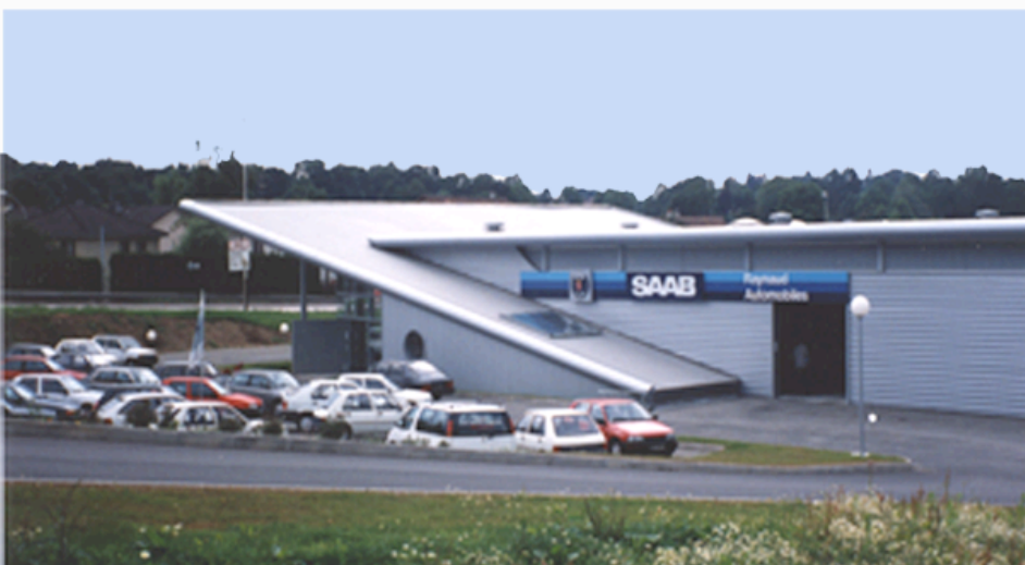
Photos de la réalisation
