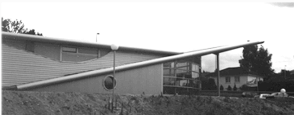
Photos de la réalisation
