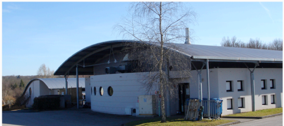
Photos de la réalisation
