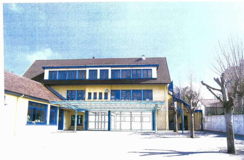
BLONVILLE-SUR-MER (CALVADOS) TRAVAUX AU GROUPE SCOLAIRE IOANA GEORGE MACKEK ARCHITECTE D.P.L.G. PERMIS DE CONSTRUIRE MAI 2005 8 VUE DES BÂTIMENTS DEPUIS LA COUR ÉTAT PROJETÉ AVEC PRÉAU
