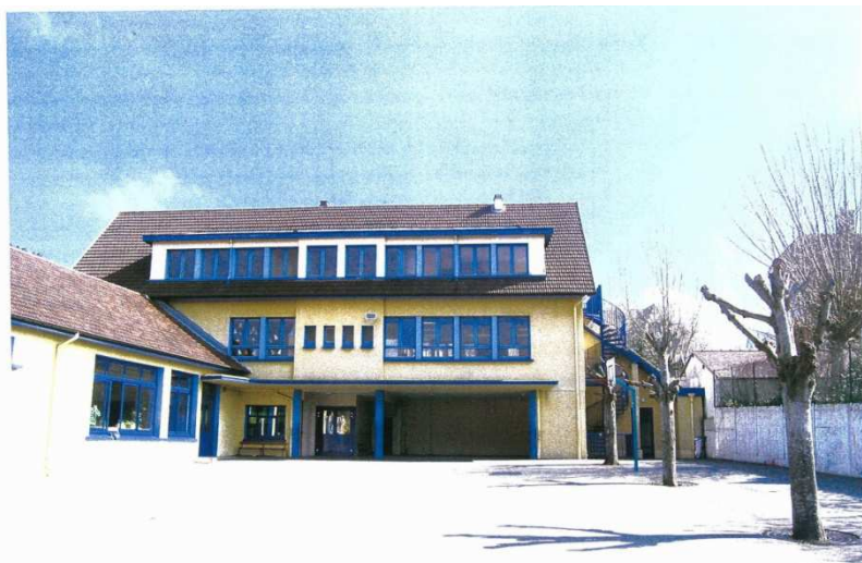
BLONVILLE-SUR-MER (CALVADOS) TRAVAUX AU GROUPE SCOLAIRE IOANA GEORGE MACKEK ARCHITECTE D.P.L.G. PERMIS DE CONSTRUIRE MAI 2005 7 VUE DES BÂTIMENTS DEPUIS LA COUR ÉTAT ACTUEL
