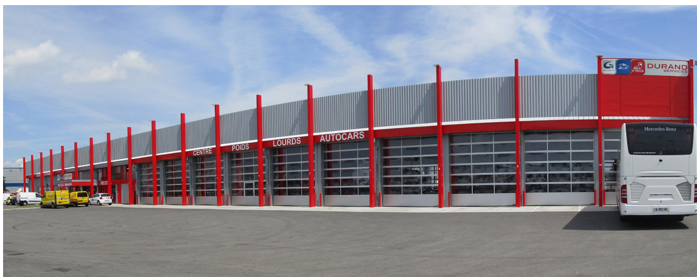
Vue de la façade Sud rénovée, parking véhicules légers et poids lourds.
