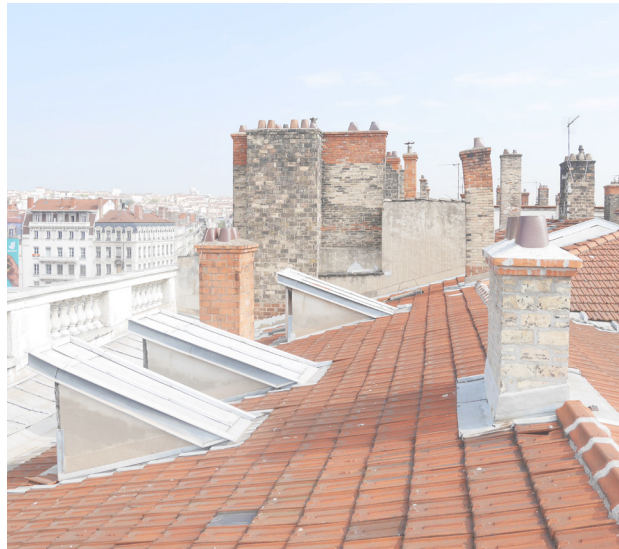
Vue depuis la toiture
