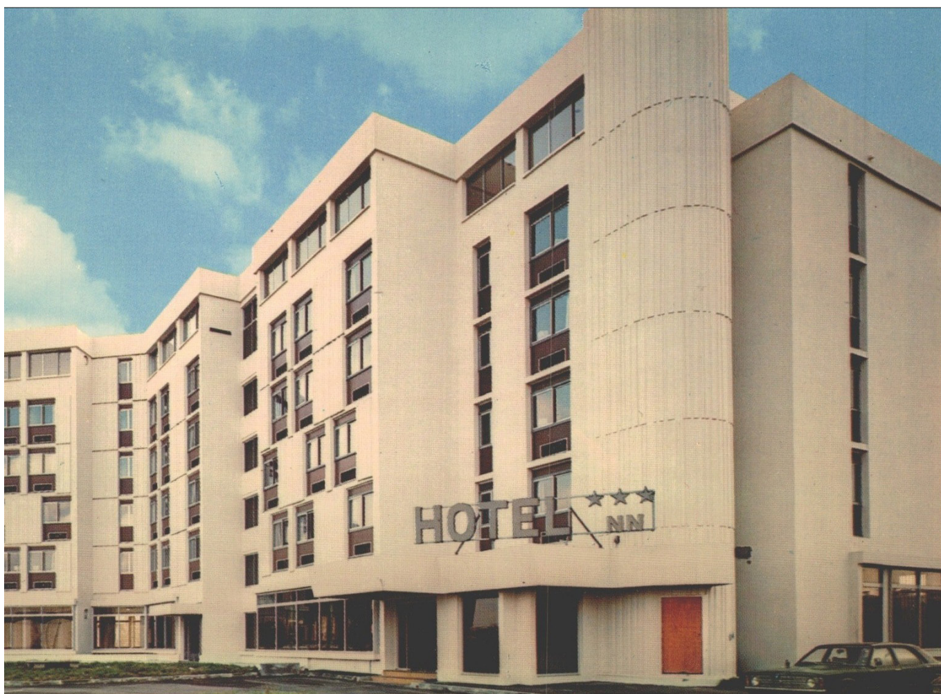
Etat d'origine de la façade dans les années 1970, source : delcampe.net.
