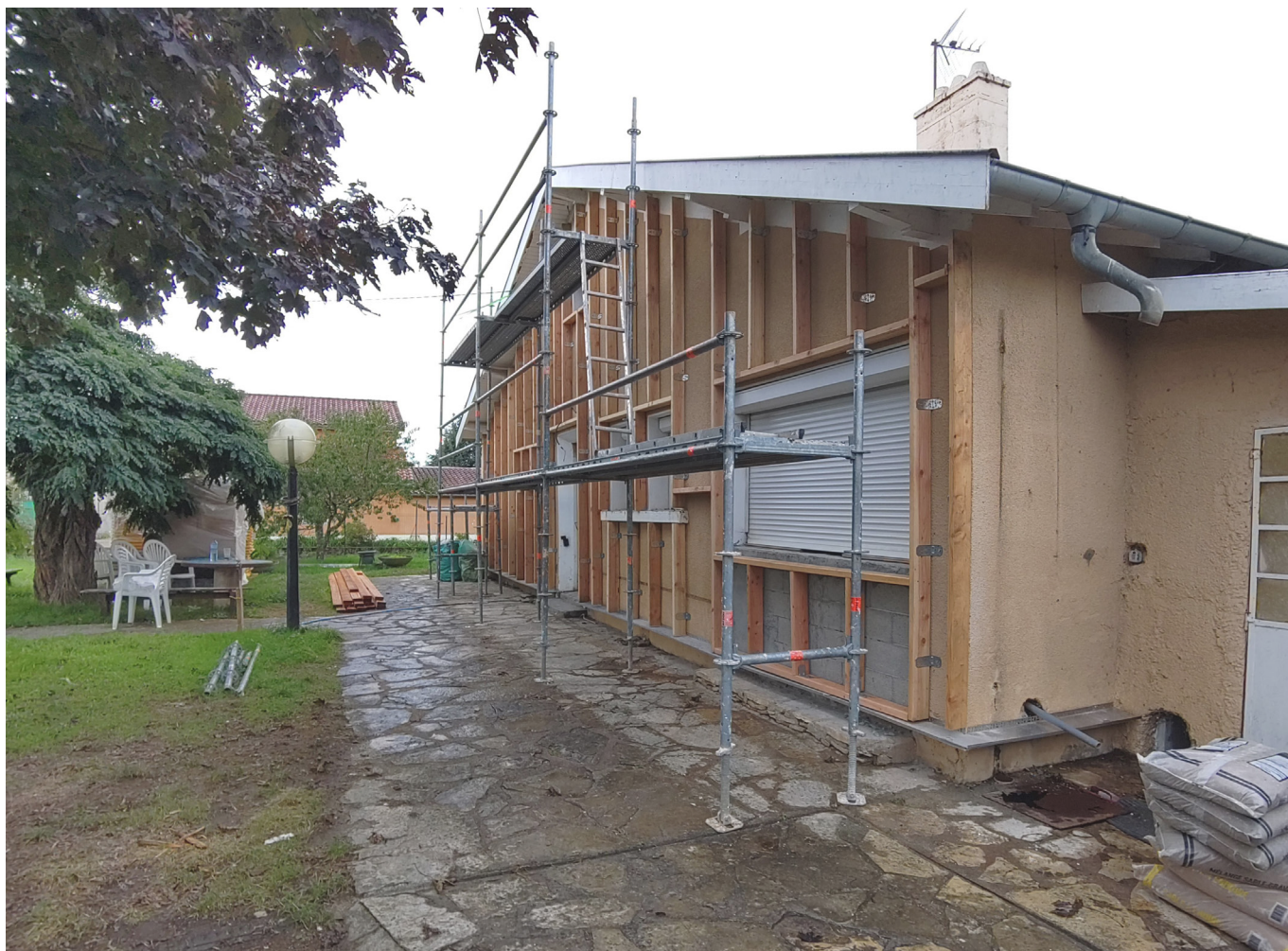
Vue actuelle du chantier : pose de l'ossature bois pour remplissage laine et fibre avant enduit
