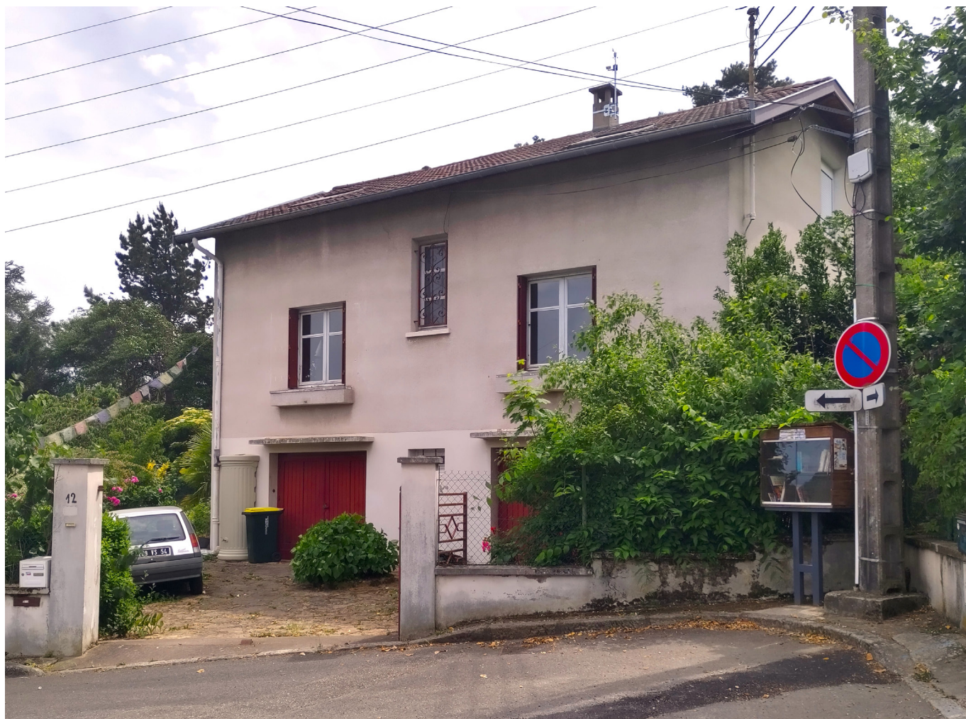
Vue de la Façade Nord depuis la rue
