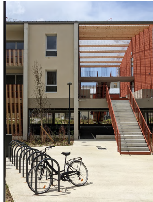
97 logements collectifs, Dijon
