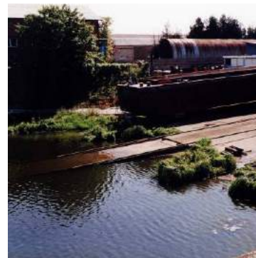
Vue de l'existant.
