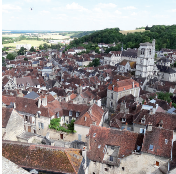
☞ Couvertures et voûtes avant travaux
