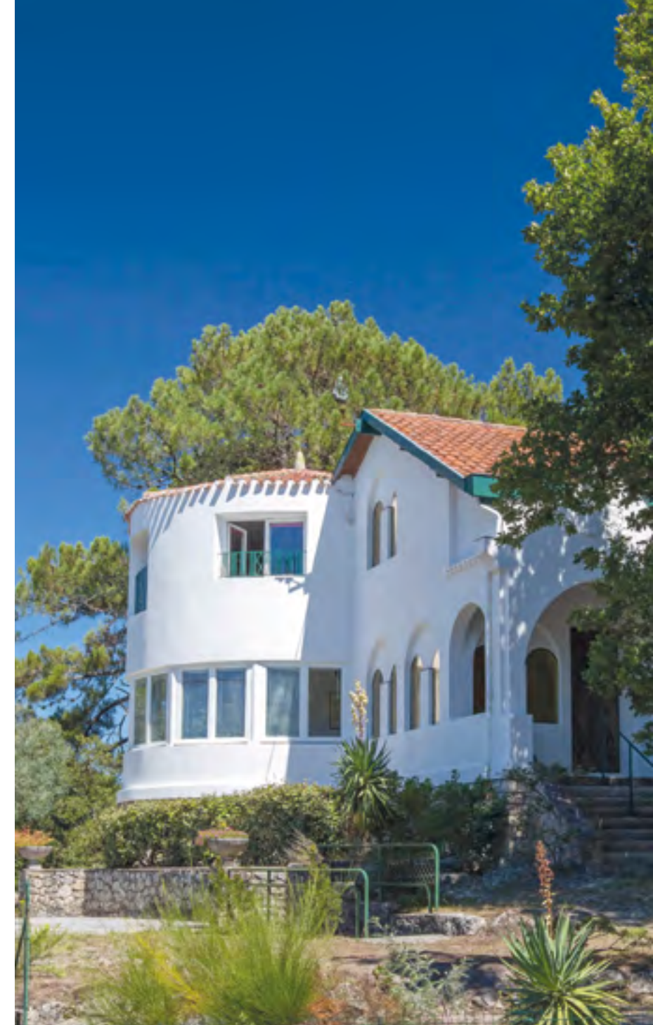
Maison FZ Extension et rénovation Carcans 33121
