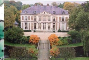
château pierres et briques (1743) avant-cour sur-élevée (1937)
