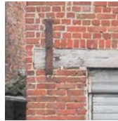
Élément structurel : Linteaux droits et appuis de fenêtre en bois Fers d'ancrage
