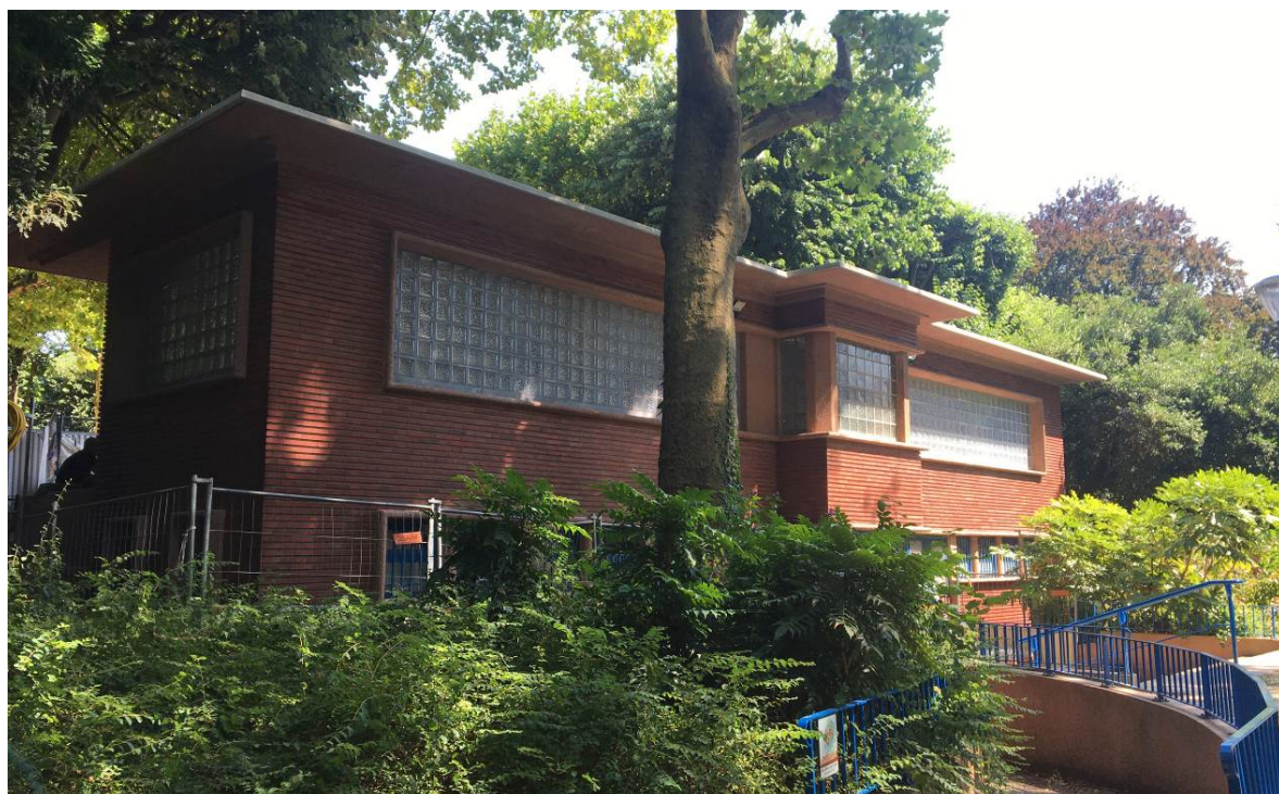
Pavillon du Belvédère – façade sud
