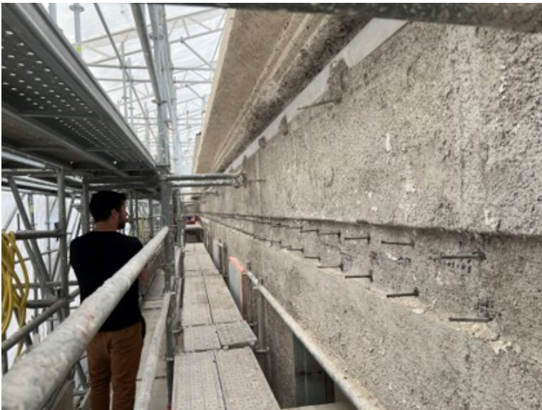
Mise en œuvre de l'isolation extérieure bio-sourcée
