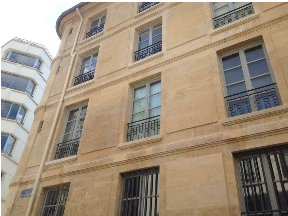
Façade rue Tournefort après restauration
