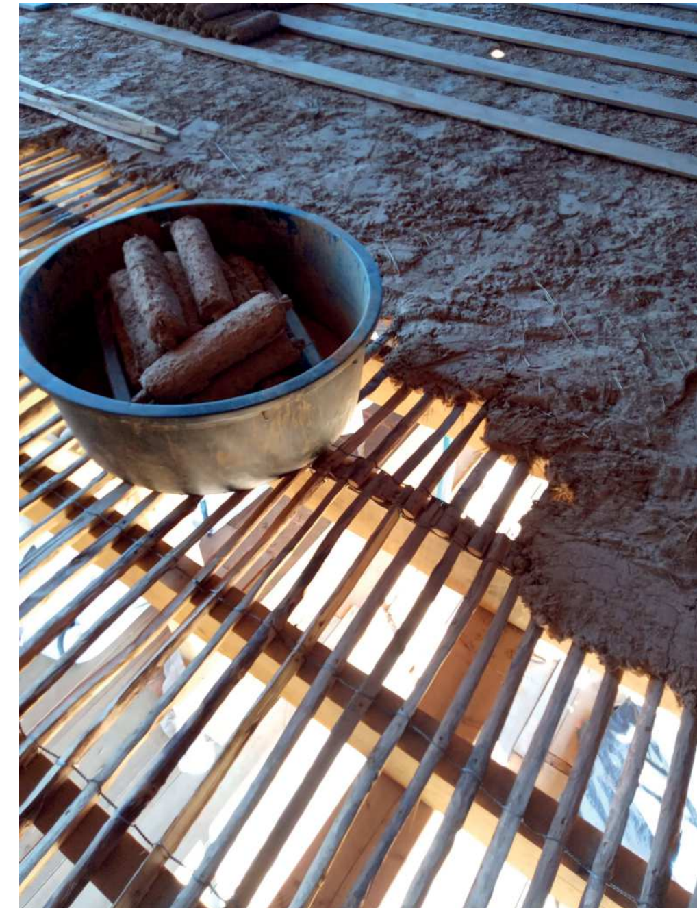
Chantier participatif - Réalisation d'un plancher en terre - Coutances - 2021
