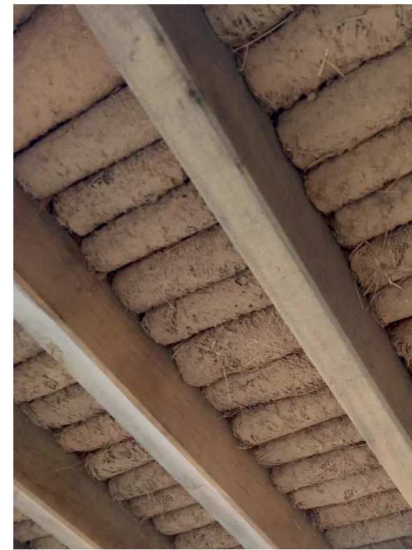
Chantier participatif - Réalisation d'un plancher en terre - Coutances - 2021
