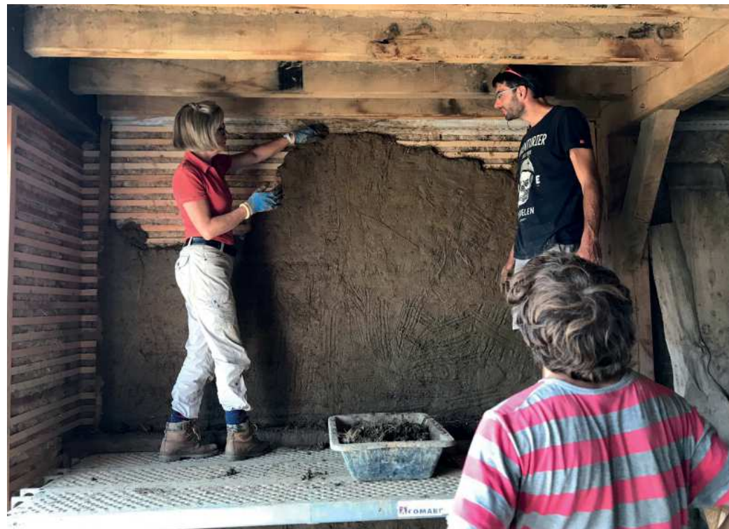
Chantier participatif - Pose d'un doublage torchis sur ossature bois - Coutances - 2022
