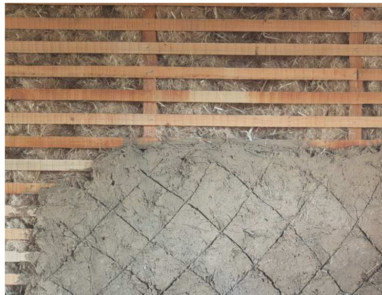
Chantier participatif - Pose d'un doublage torchis sur ossature bois - Coutances - 2022
