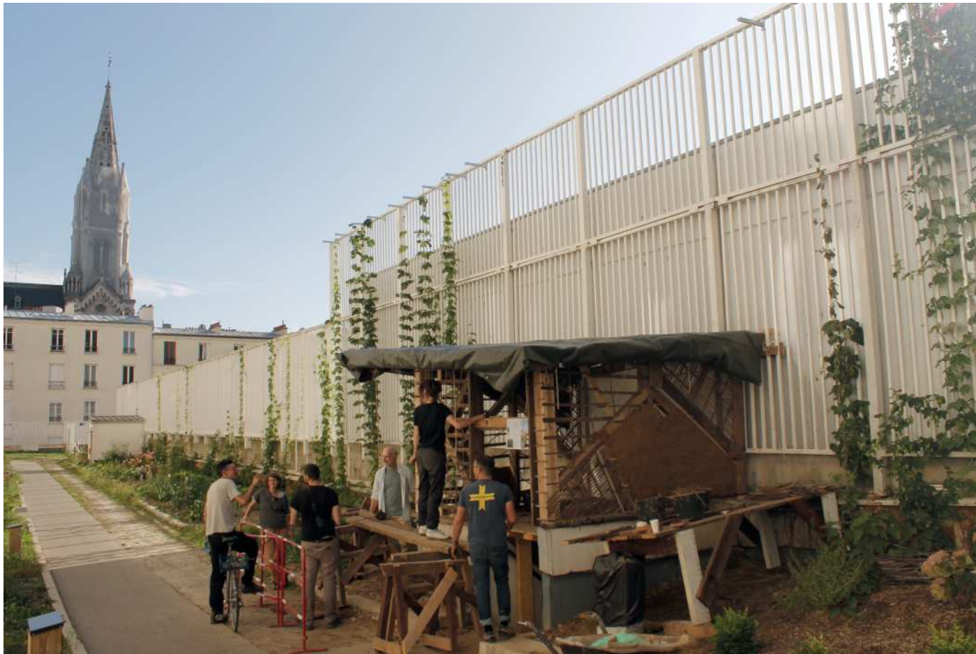
Atelier pédagogique avec des étudiants. Réalisation d'un torchis sur ossature bois - Couronnes- 2024
