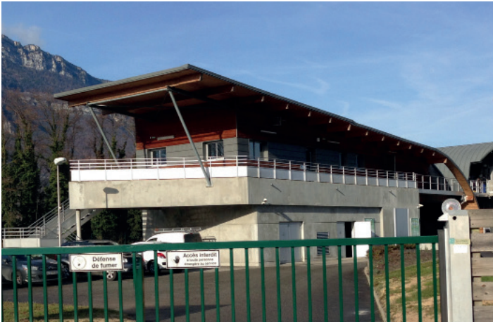
Vues depuis le chemin d'accès avant intervention
