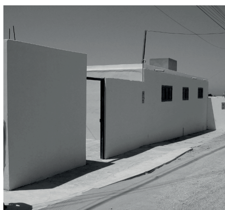
FAÇADE AVANT TRAVAUX
