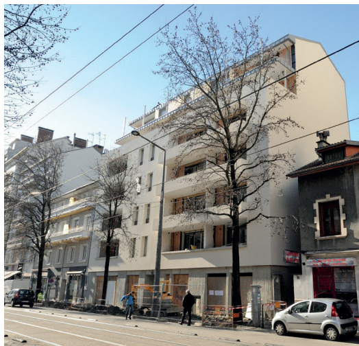
photo chantier en cours
