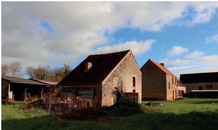
HÉRITAGE D'UN BÂTI ANCIEN Barou-en-Auge Photo: Autrice, 2024
