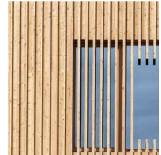
Référence : Joints de recouvrement devant les menuiseries
