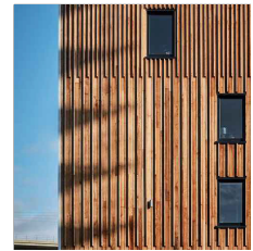
Référence : Bardage bois avec joints de recouvrement
