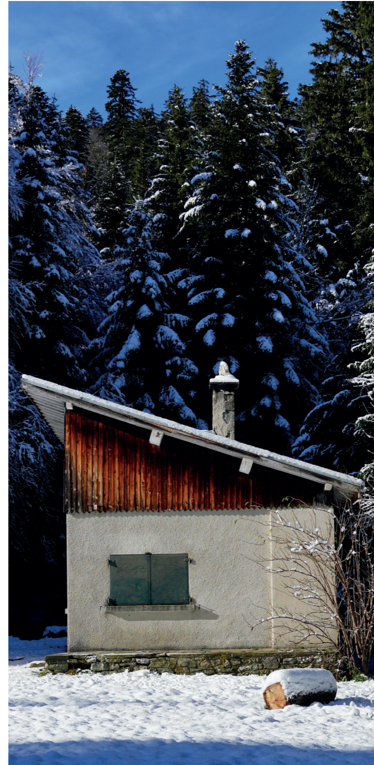
PHOTO FAÇADE EST
