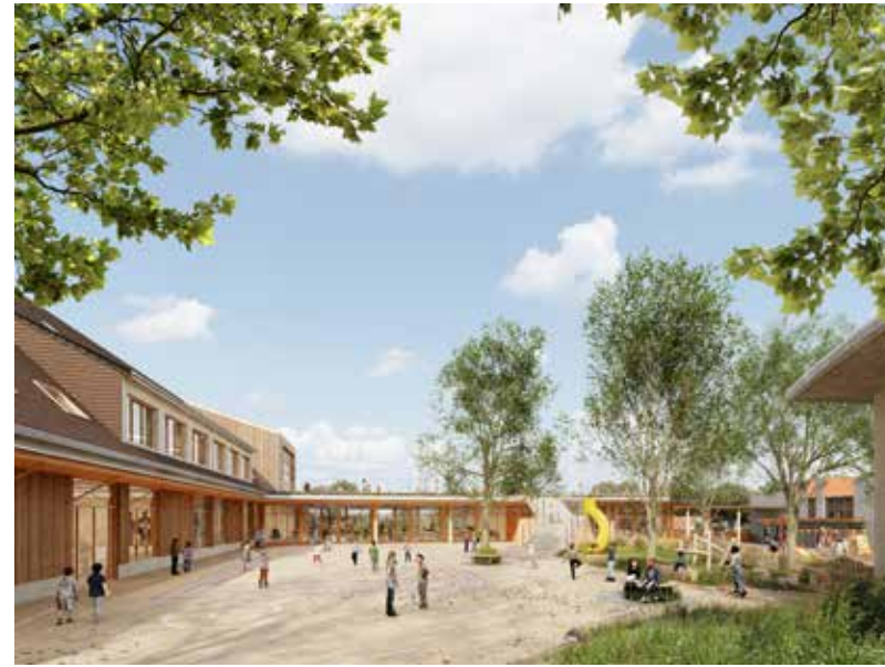
Vue de l'extension depuis la cour élémentaire
