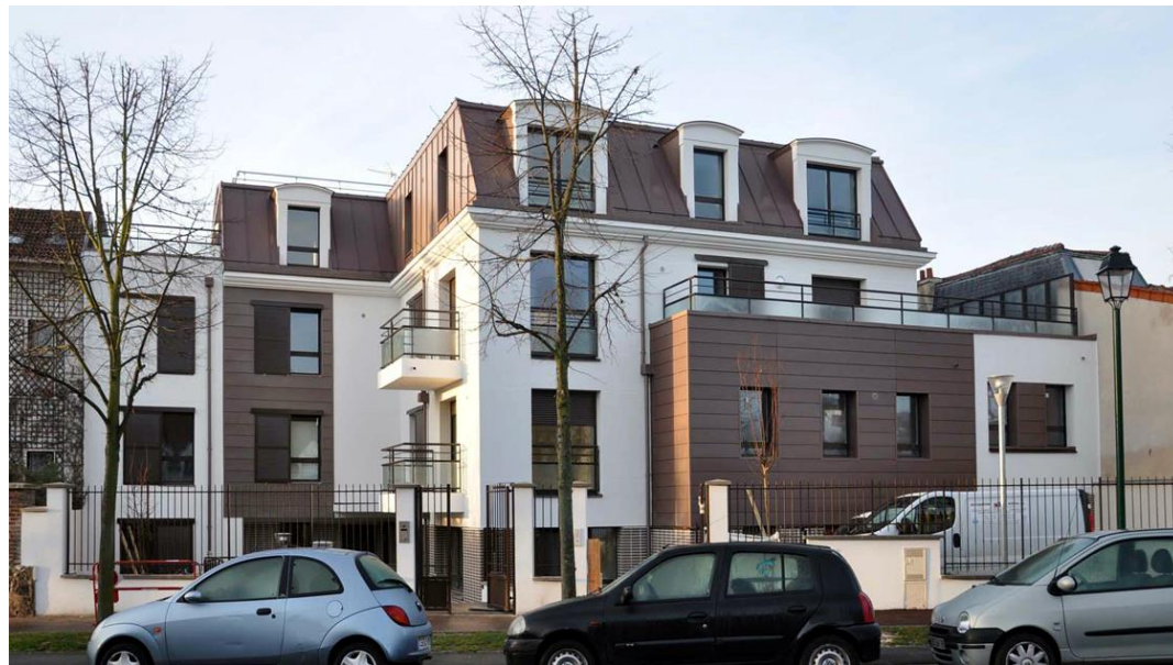
Vue avenue du Général de Gaulle
