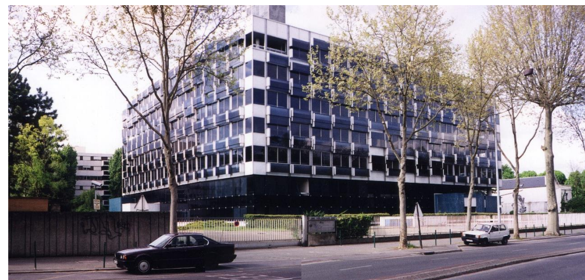
Vue avant travaux
