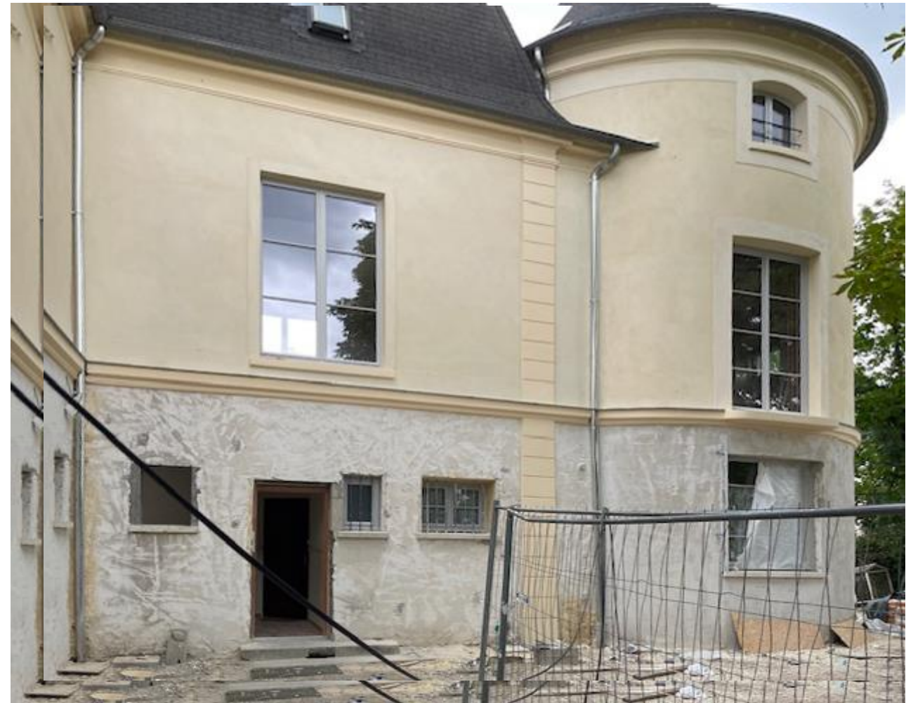
Travaux de ravalement
