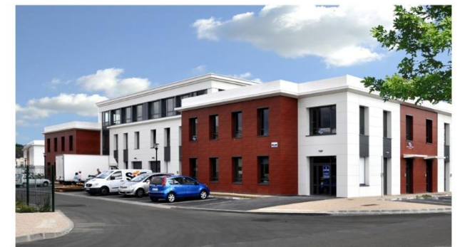
Vue du bâtiment A
