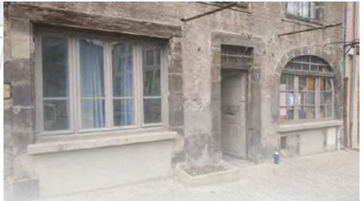
VUE ETAT ACTUEL - DETAIL DES BAIES EN REZ DE RUE
