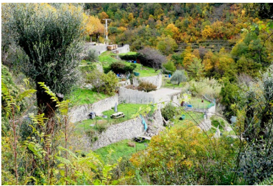
Terrasses et restanques Sud
