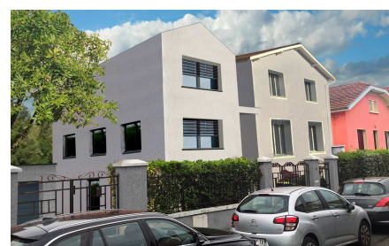
Surélévation maison du STADE, Bron (69)
