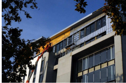
Siège de la chambre régionale de commerce, Lyon
