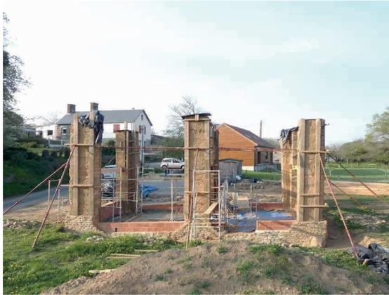
1. Six piliers structurels sont réalisés en bauge
