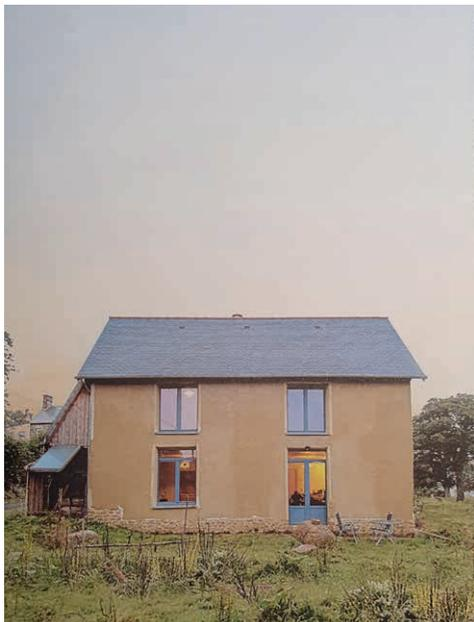
**Fig.30.** La maison, type pavillon, a été construite avec des matériaux bio-sourcés. Elle est devenue une référence car même sa structure est écologique : elle est en bauge.
