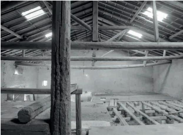
Fig.13. Photo avant la réhabilitation pour le projet de boulangerie, on y voit la charpente typique des fermes lorraines.
