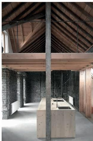
Fig.27-28. Le mâchefer des murs comme matériau de finition
