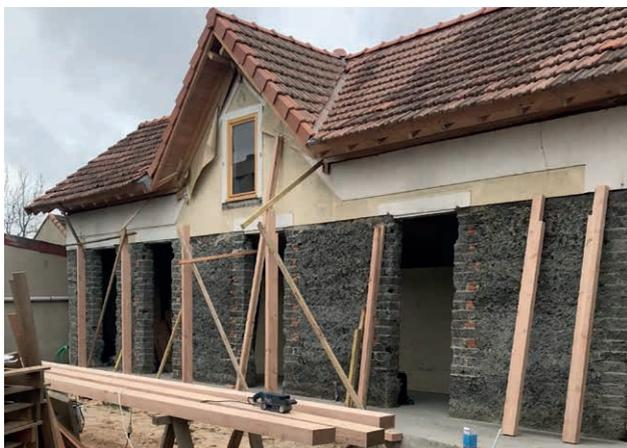
Fig.25. La maison lors de la phase de « purge ». Le mâchefer propre à la composition des murs est mis à nu.
