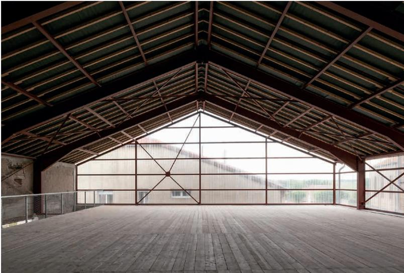
Fig.14. Photo après travaux, on peut apprécier la nouvelle charpente métallique qui libère tout l'espace en R+1.
