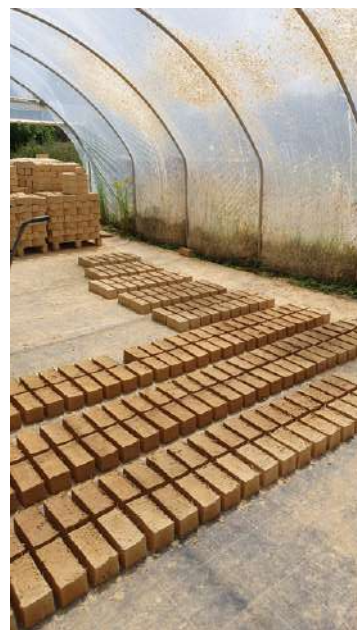
▼ RÉALISATION D'ADOBE Redon ( Bretagne ) Chantier accompagné par un maçon certifié
