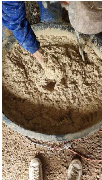
▲ ENDUITS DE FINITION EN TERRE CRUE Caden ( Bretagne ) Chantier accompagné par une maçonne spécialisée
