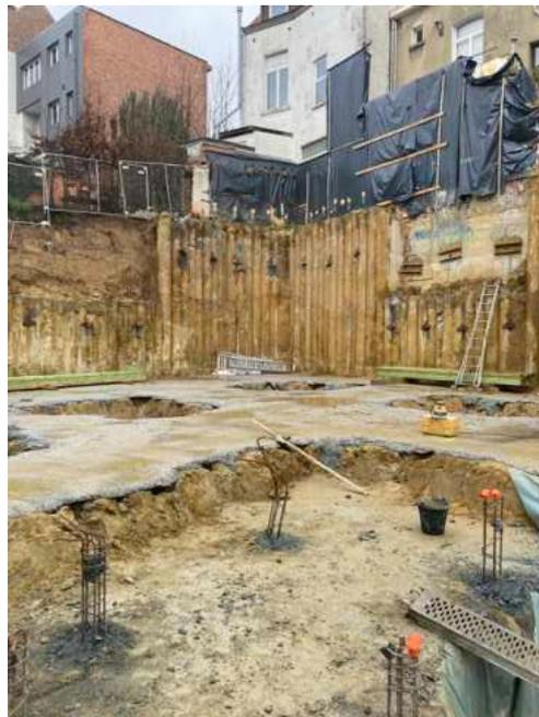
Dues à la fragilité du sol (sable) et à sa proximité avec la nappe phréatique, les fondations ont été réalisées en pieux forés et pieux sécants. Une poutre de ceinture a été posée afin de sécuriser les bâtiments mitoyens. Cet ouvrage structurel d'une grande importance a impliqué des coûts et des délais supplémentaires non négligeables.
