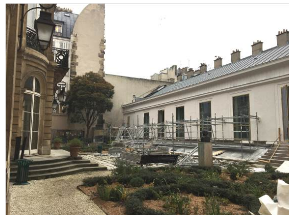
Chantier en cours – Janvier 2025
