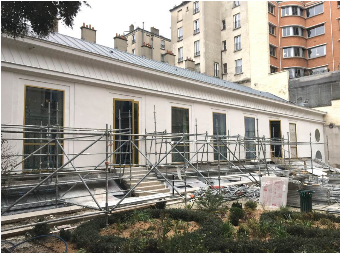
Façade projet de la salle Rossini – chantier en cours.
