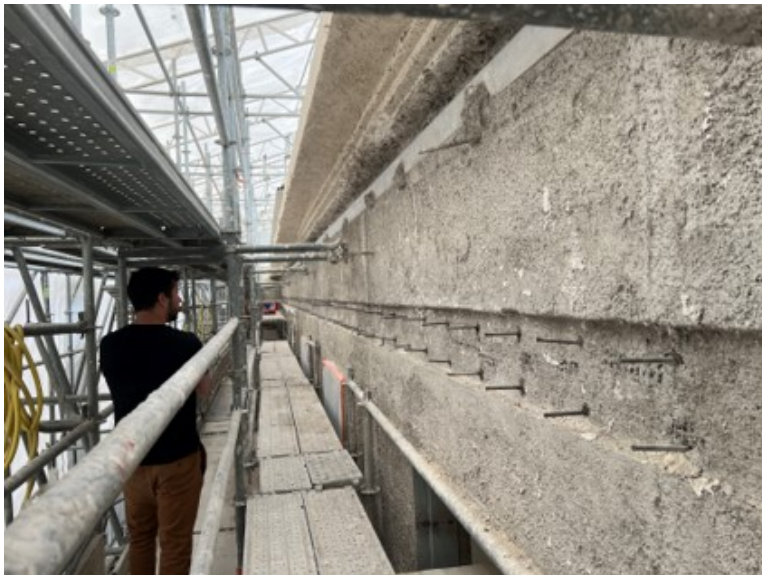
Mise en œuvre de l'isolation extérieure bio-sourcée
