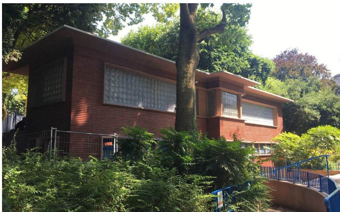
Pavillon du Belvédère – façade sud
