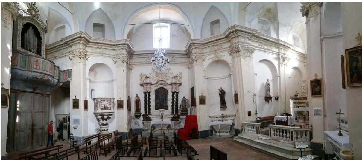
Vue générale de la nef
