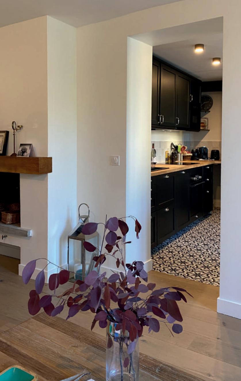
Vue depuis le séjour vers la cuisine - ouverture du mur porteur anciennement fermé. Copyright AANR
