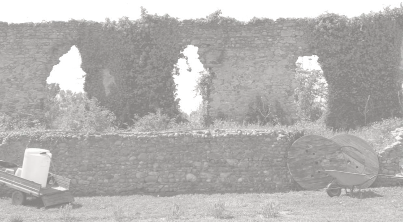
Relevé photographique du site
