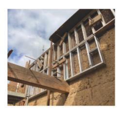
Les murs sont uniquement composés de terre issue d'une carrière locale, de roseau broyé, et de lin déclassé. La mise en œuvre permet de réduire le coût de la bauge et de répondre à la RE2020.
