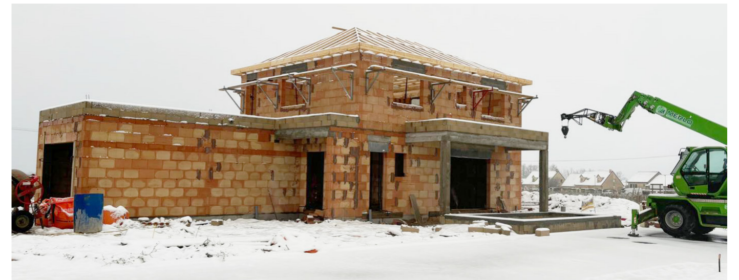
Image de chantier - Novembre 2024
