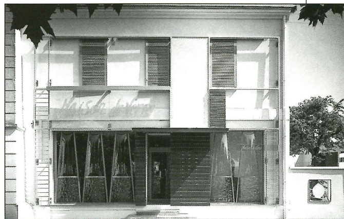
La façade sur rue du Musée du Verre est traitée en verre bombé et thermoformé.
