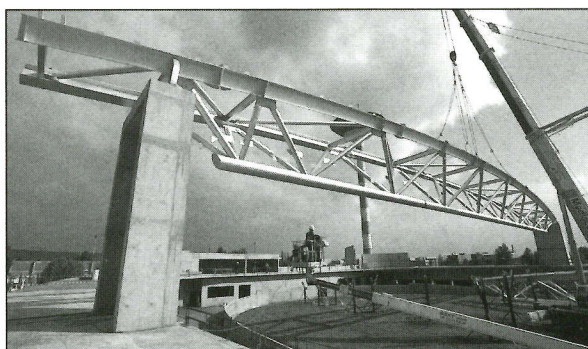
D'une portée de 75 mètres, chaque poutre principale pèse 90 tonnes.
