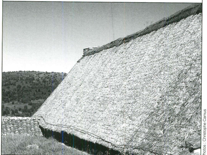
Le chaume, un vrai toit "bio"... mais qui doit être réalisé dans des conditions techniques "zéro défaut". Sinon, les rongeurs aussi sont bio...
