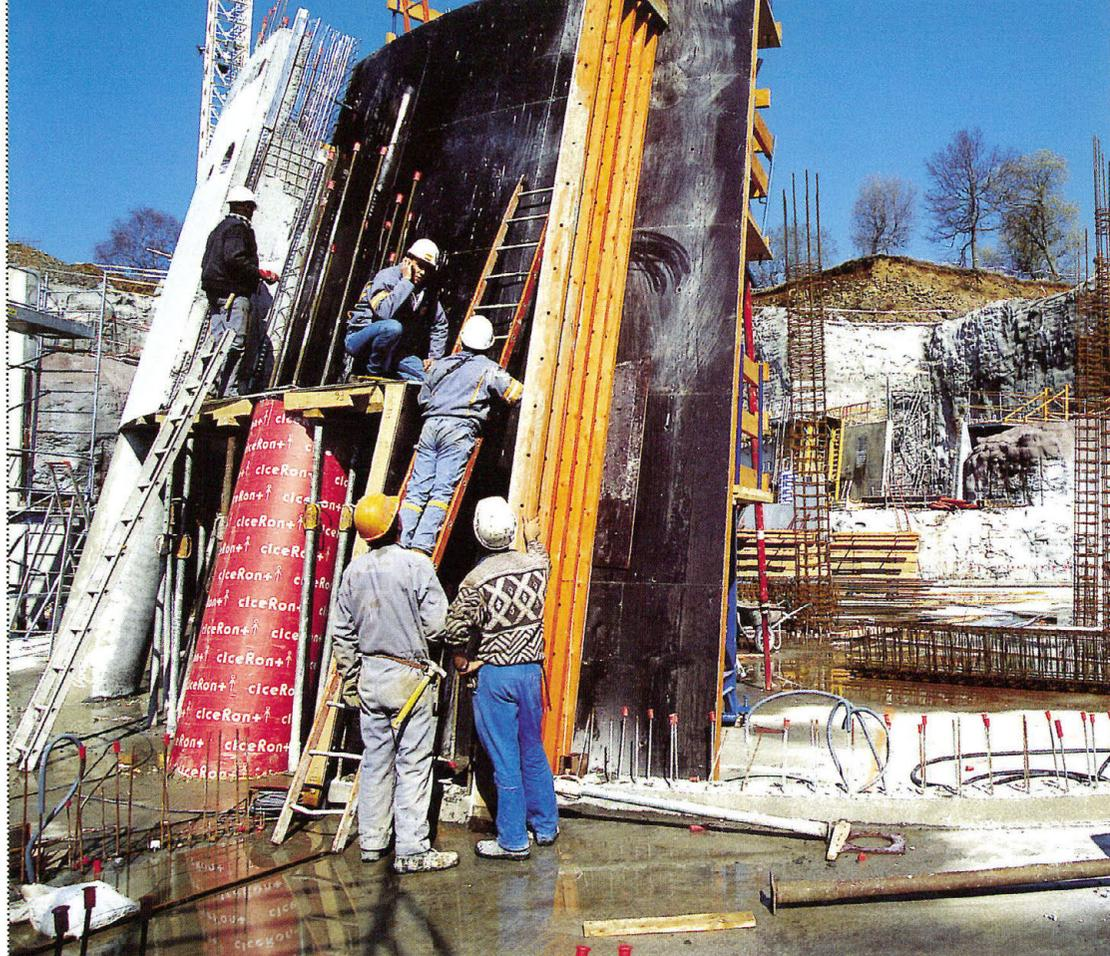
La mise en œuvre des piliers soutenant le cône. Ce chantier très technique a exigé beaucoup d'études avant que ne se prennent les décisions. Aller doucement, certes, mais sans perdre de temps, car les délais d'études et, surtout, d'exécution ne le permettaient pas.
