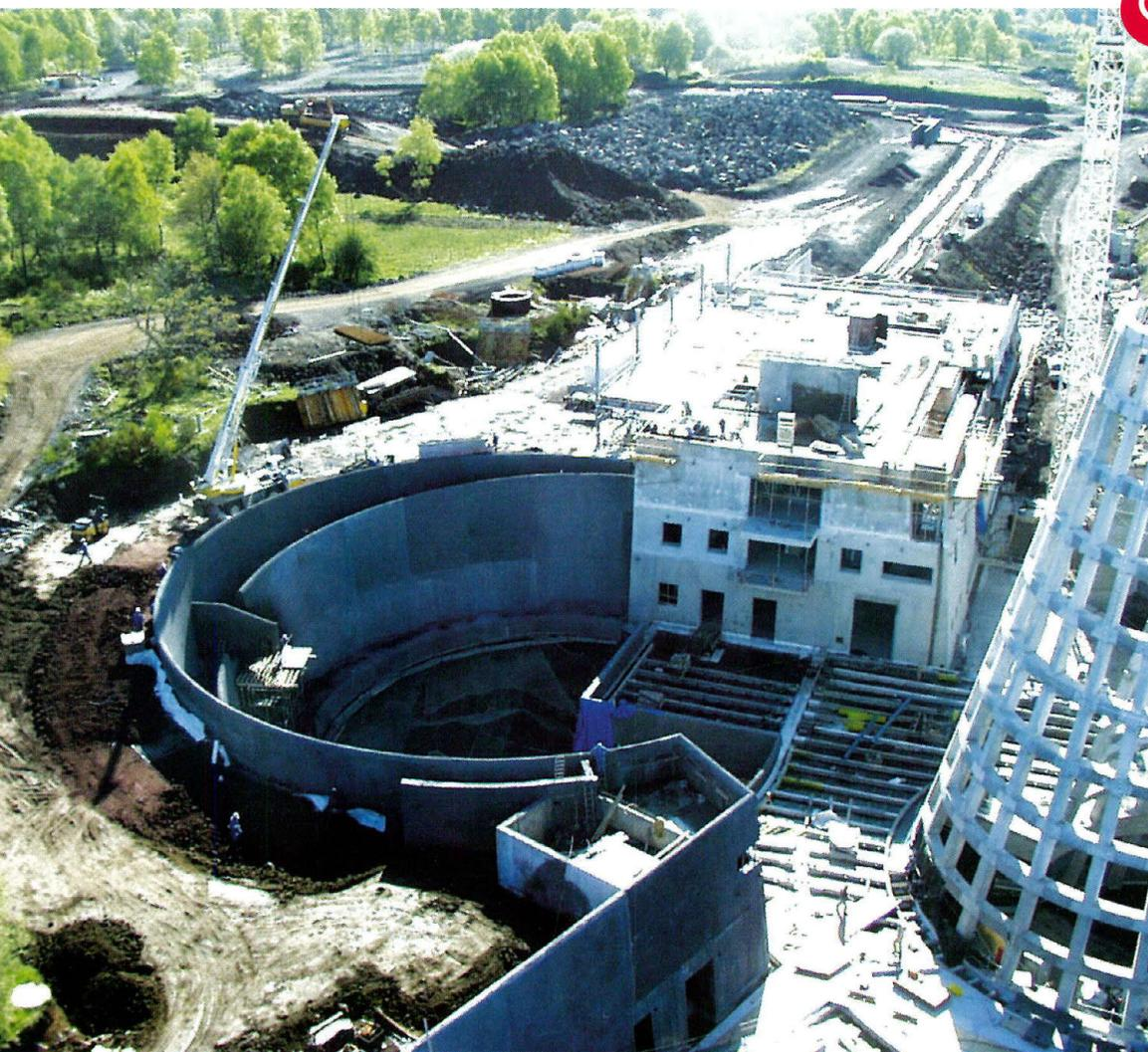
Un voile de béton armé et coloré a été projeté dans le cratère (à gauche sur la photo), accompagné d'un treillis et de tirants d'ancrage en vue de stabiliser la pouzzolane, déposée là, il y a des milliers d'années.
