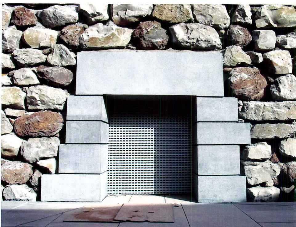
Le renouvellement de l'air est assuré par ces grilles, situées ici au niveau du mur cyclopéen.
