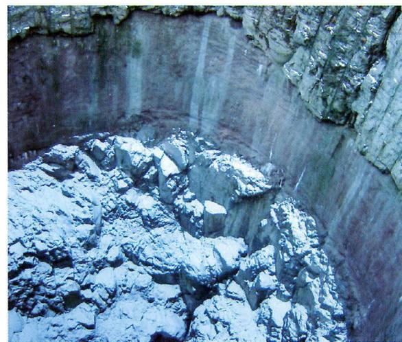
Pour renforcer les parties trop fragiles, en particulier, dans certaines galeries et le cratère creusé lors des travaux (ci-dessus), la roche fut colmatée au coup par coup par des spécialistes, avec du béton projeté (armé ou non) sur des épaisseurs variant de 5 à 15 centimètres.
