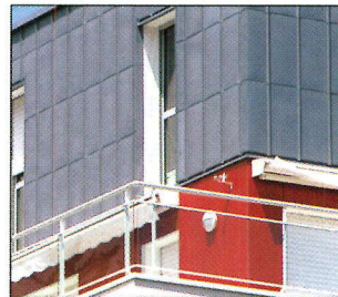
Immeuble "Sequoia" - Rennes (35) Architecte : Golhem / Entreprise : SOPREMA
