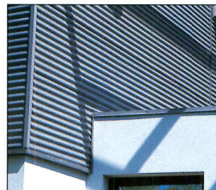
Immeuble bureaux - Arradon (56) Architecte : Gueho / Entreprise : HAYS
