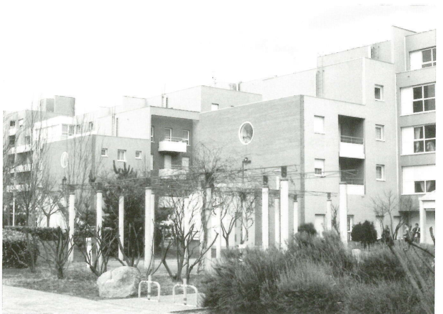
Un soin particulier a été accordé aux espaces extérieurs : pergolas, passerelles, pièces d'eau.
