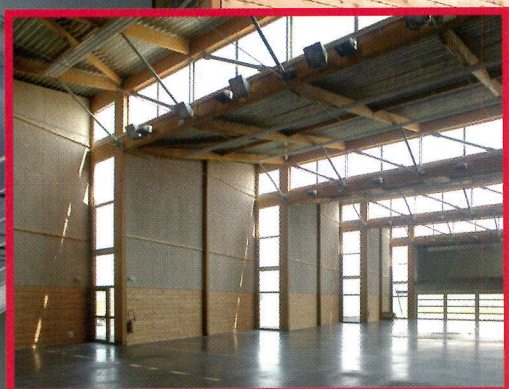
Un duo entre le béton et le bois que les architectes ont privilégié tant à l'intérieur qu'à l'extérieur. L'architecture permet un éclairage optimum.
