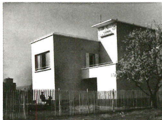
Vue du nord-est ; au 1 er étage, terrasse pour les repas accessible depuis la cuisine ; au-dessus, pigeonnier décoré d'une peinture de Louis Dussour (toujours visible).
