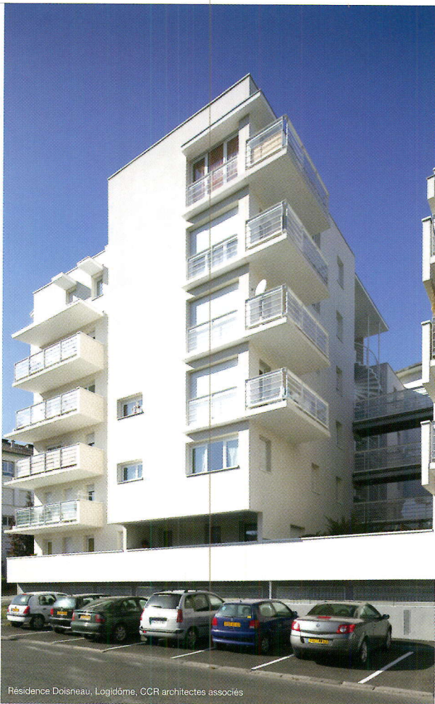
Résidence Dolsneau, Logidôme, CCR architectes associés
