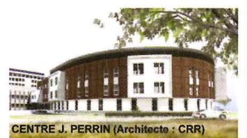
CENTRE J. PERRIN (Architecte : CRR)
