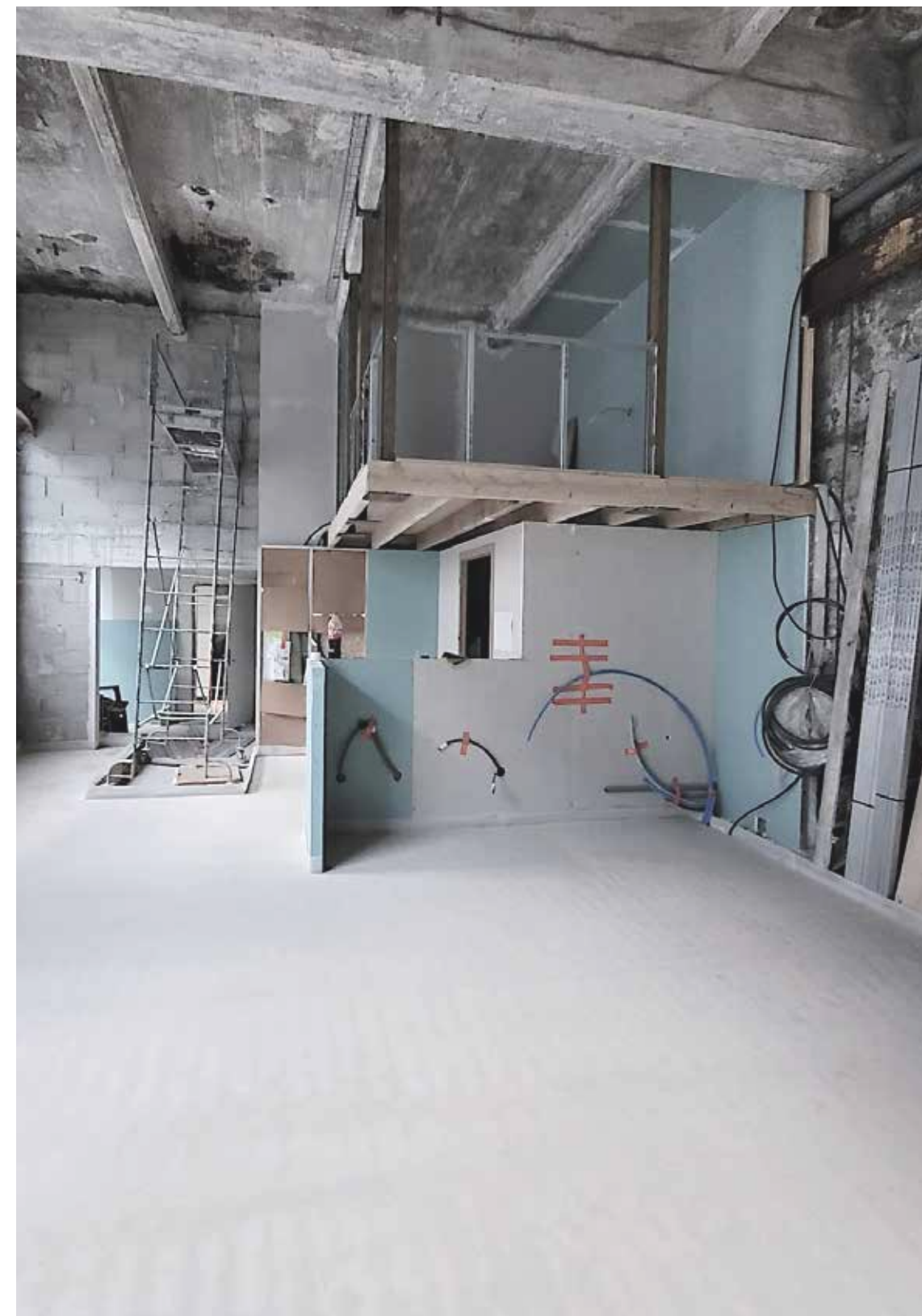
IMAGE DE LA MEZZANINE EN COUR DE TRAVAUX
