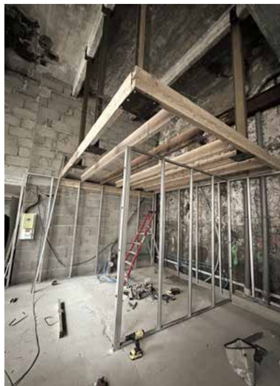
IMAGE STRCUTURE EN BOIS ET RAILS DU WC EN RDC
