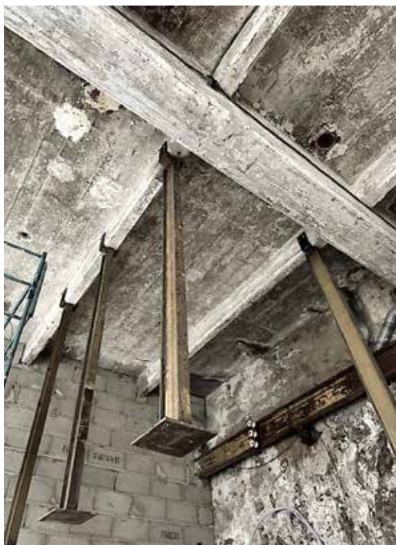
MISE EN PLACE DES POTEAUX EN TRACTION
