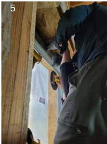
Maison en autoconstruction boispaille 1 Photo de pose isolation de laine de bois en toiture 2 Photo d'intérieur avec les menuiseries de triples vitrages 3 Photo de menuiserie en attente de pose 4 Photo de pose d'une menuiserie 5
