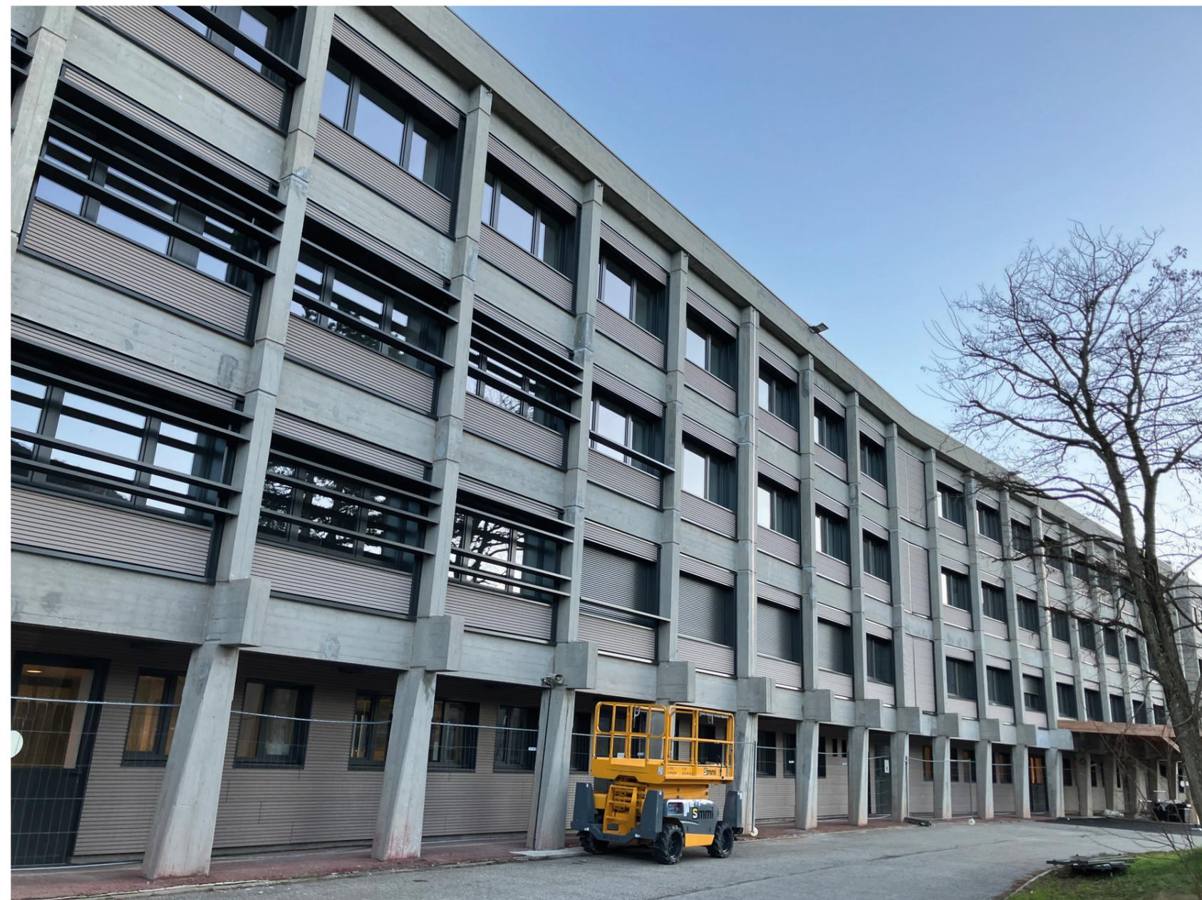
Figure 4.4 : Photographie de la façade Sud (pose des brise-soleil en cours), Maëlle Poussin
