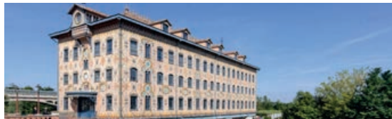
Projet de réhabilitation de la chocolaterie de Noisiel (77)
