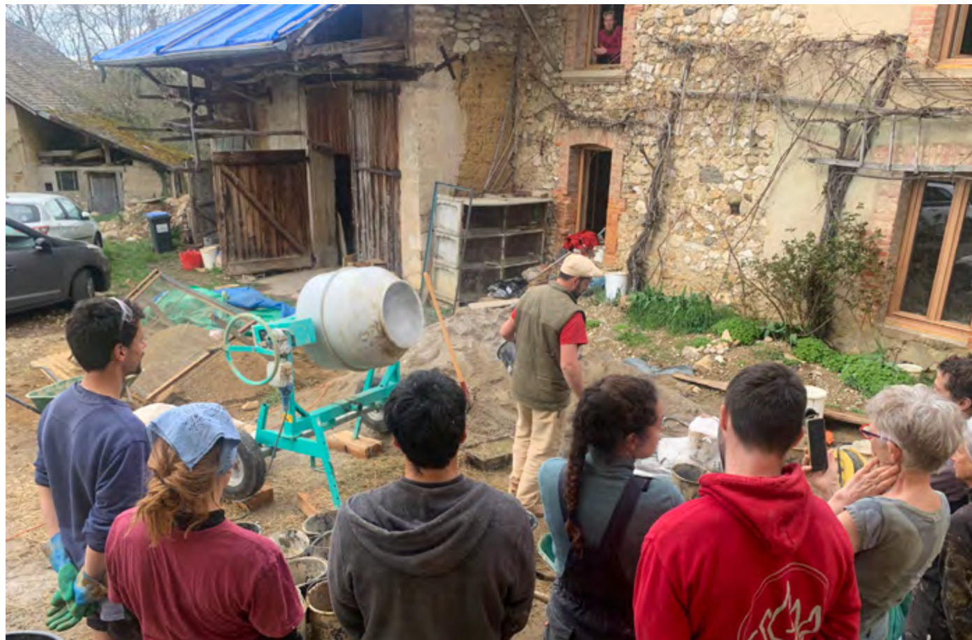
Photographie du chantier
