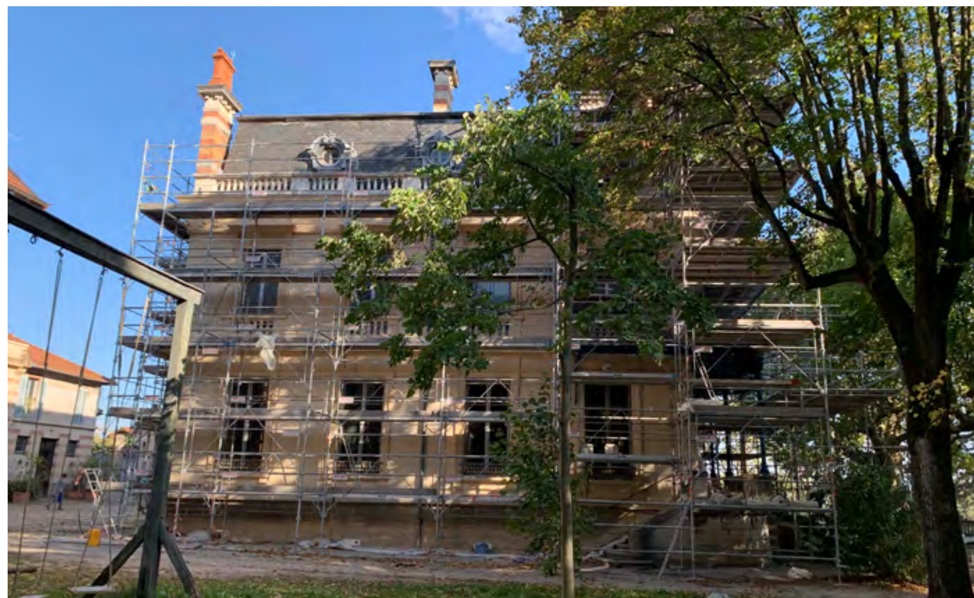
Photographie du chantier
