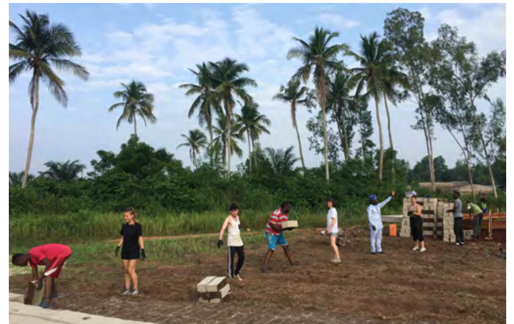
Photographies du chantier
